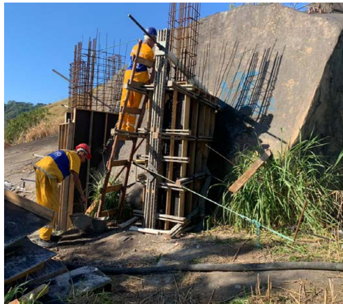
Execução de formas dos contrafortes
