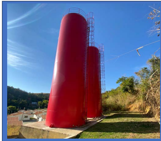
Instalação de Reservatório
