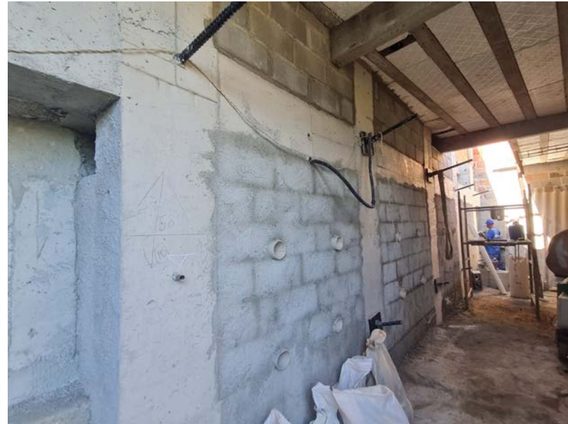
Execução da grelha atirantada.
