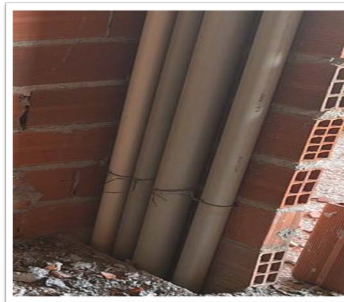
Instalações dos tubos para esgoto
