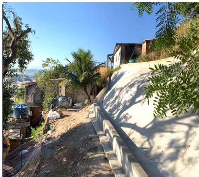
Concreto projetado e viga estaqueada executados
