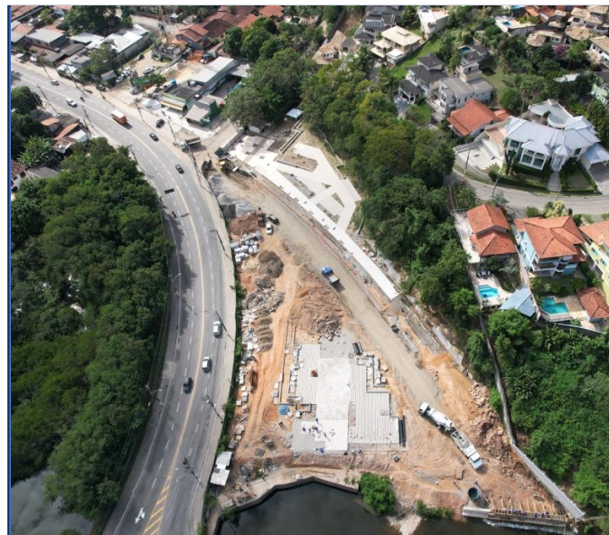
CANTEIRO/ OBRA ATUAL
