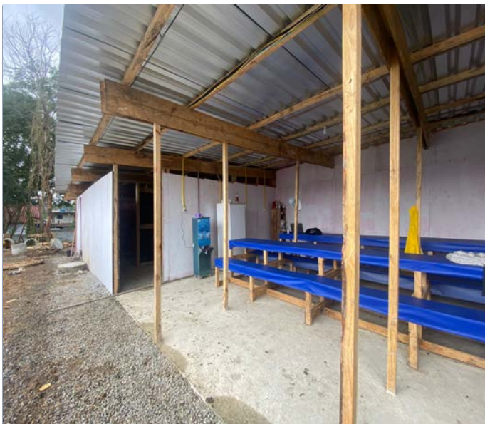
CANTEIRO DE OBRAS
