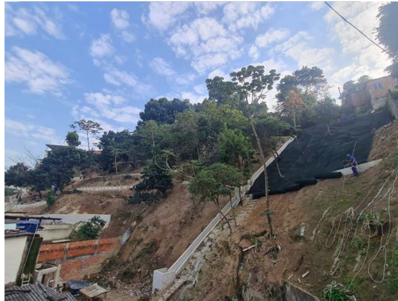
Execução de calhas, escadas hidráulicas e solo grampeado revestido com geomanta.
