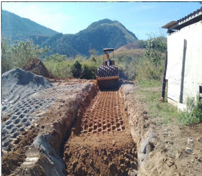
Drenagem pluvial – Compactação do Solo
