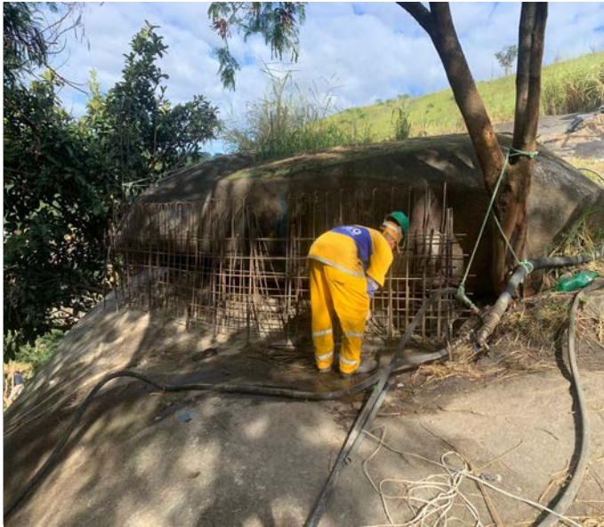
Execução de armadura da mureta chumbada
