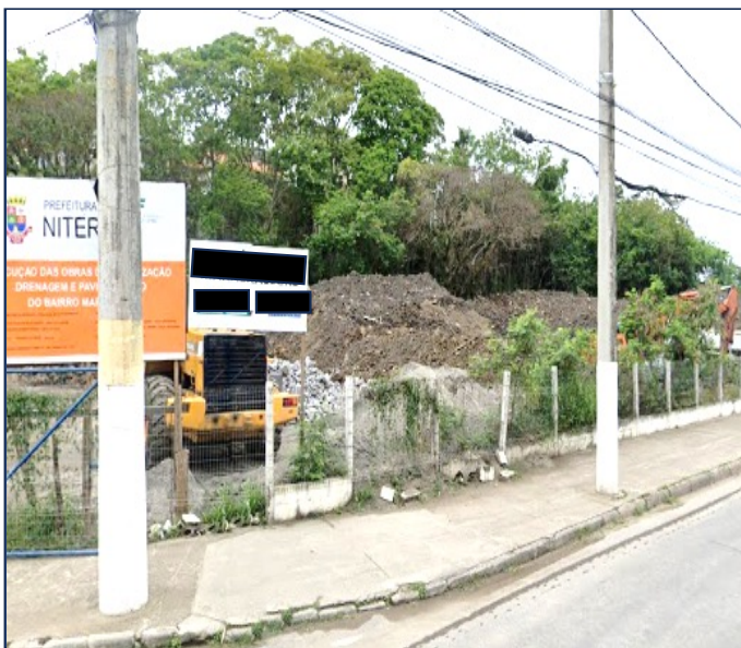
CANTEIRO/ LOCAL DA OBRA 2021
