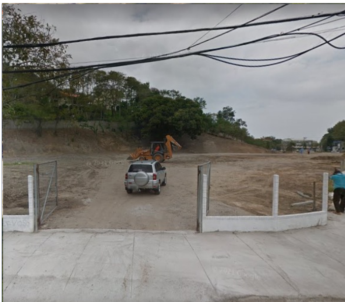
CANTEIRO/ LOCAL DA OBRA 2021
