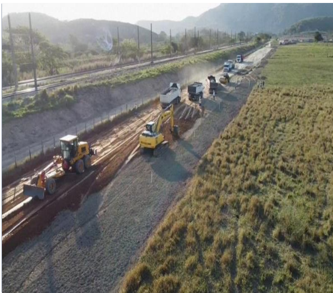
Terraplanagem (ref. de subleito e sub-base)
