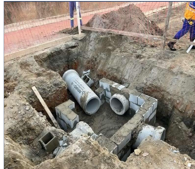
Execução de PV, Ramal e Caixa Ralo
