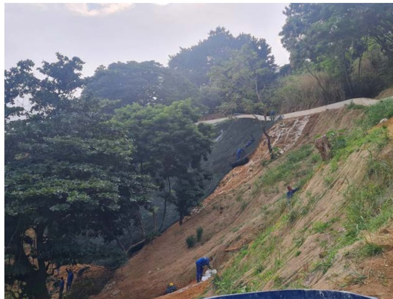
Instalação de biomanta e geomanta.
