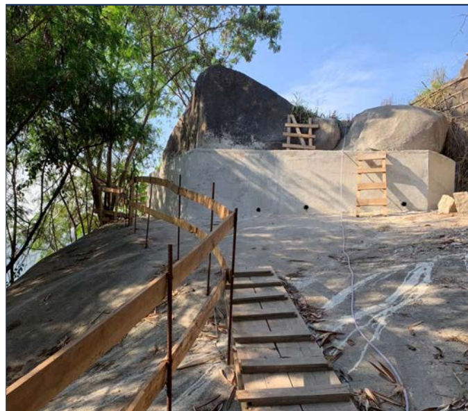
Mureta chumbada executada.
