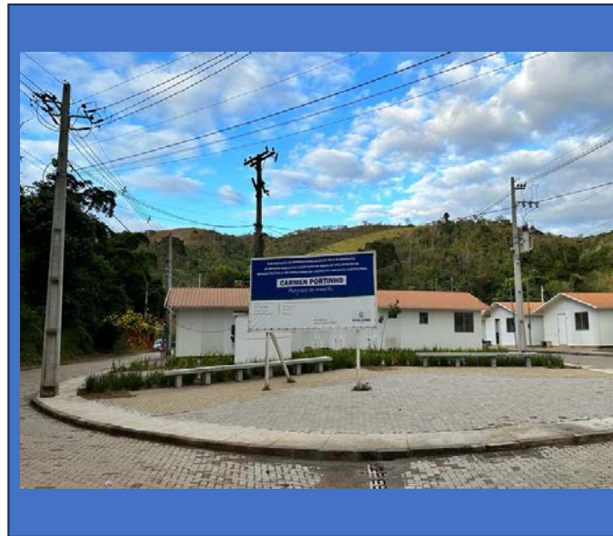
Pavimentação de intertravado e execução de calçada
