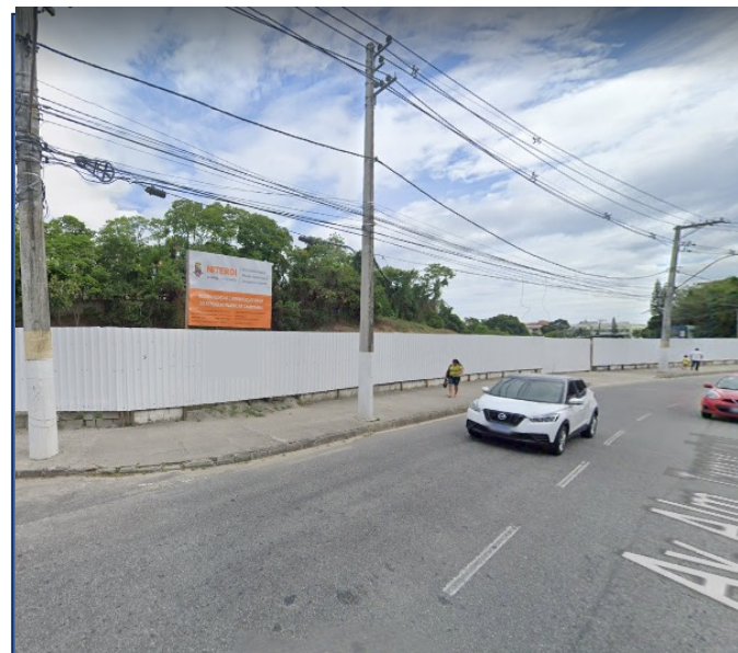
CANTEIRO/ OBRA ATUAL
