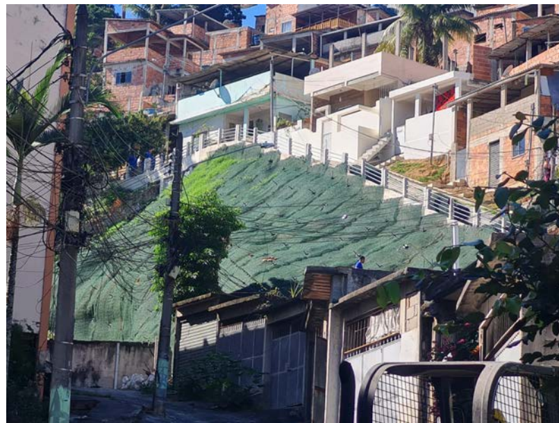
Solo grampeado e guarda corpo finalizado.
