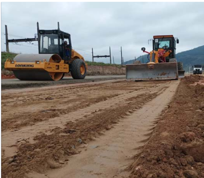
Terraplanagem (ref. de subleito e sub-base)
