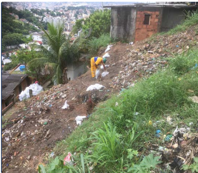
Limpeza da área do concreto projetado
