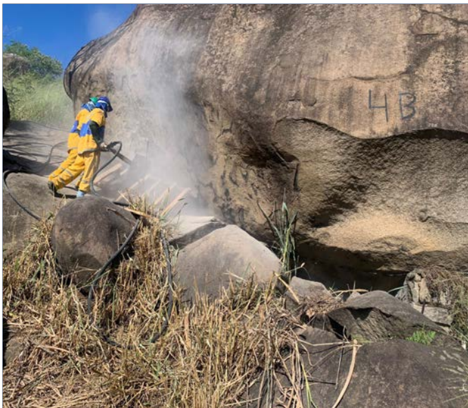
Perfuração para execução de contrafortes
