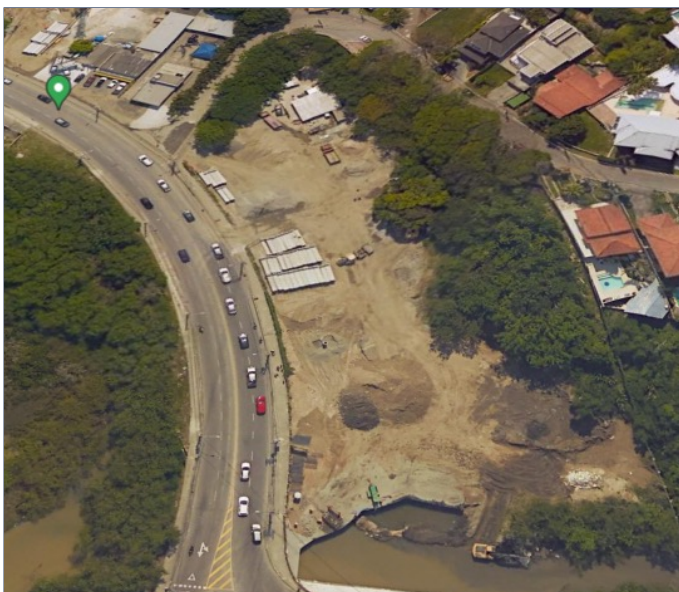
CANTEIRO/ LOCAL DA OBRA 2021
