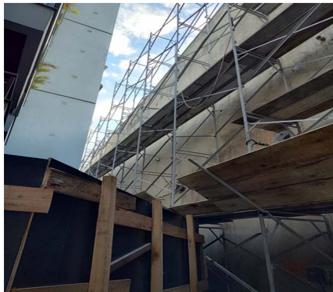
Montagem de andaime, tapume, travamento de andaime com cabo de aço.
