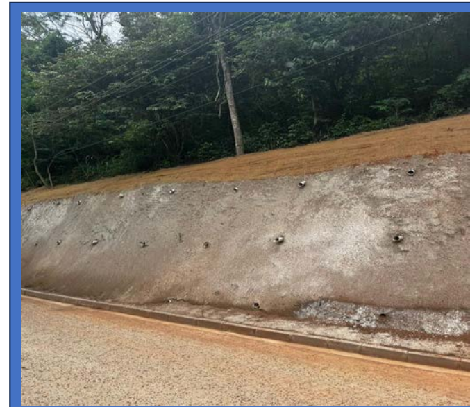
Execução de Contenções
