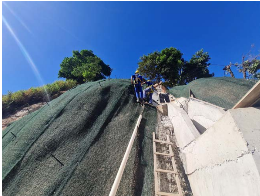
Execução da escada hidráulica e instalação da tela de alta resistência.
