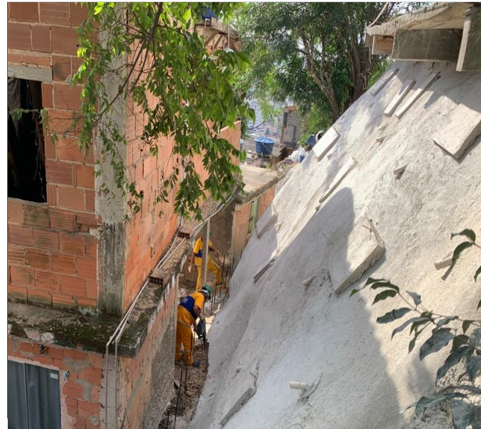
Solo grampeado com viga chumbada
