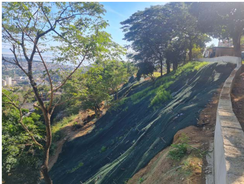
Execução de solo grampeado revestido com tela de alta resistência.
