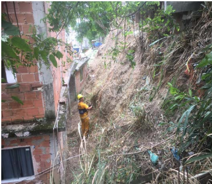
Limpeza da área de intervenção
