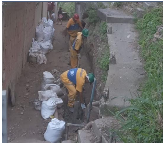
Execução de escavação para implantação de muro chumbado
