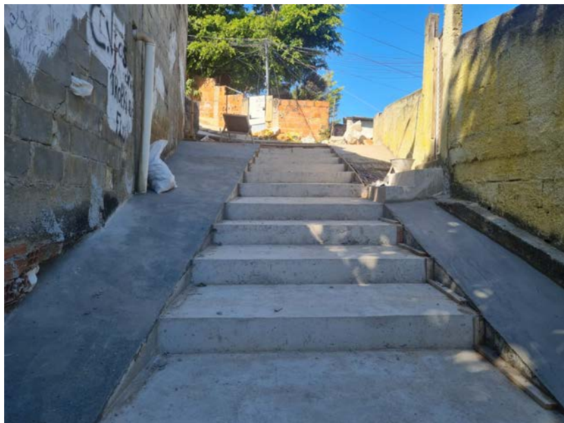
Execução de escada de acesso.
