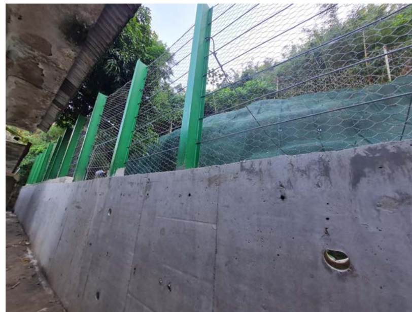
Finalização da barreira de impacto rígida.
