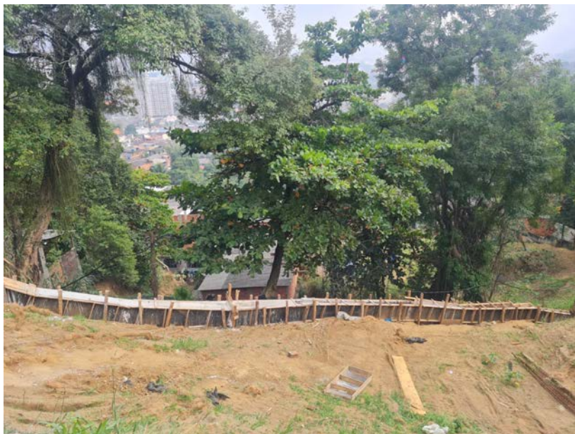
Execução de calhas.
