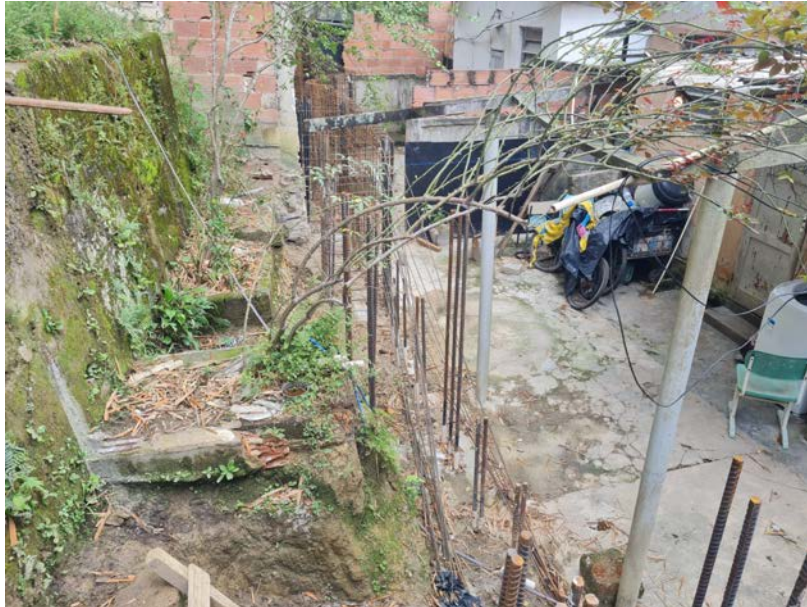
Local no início da intervenção.
