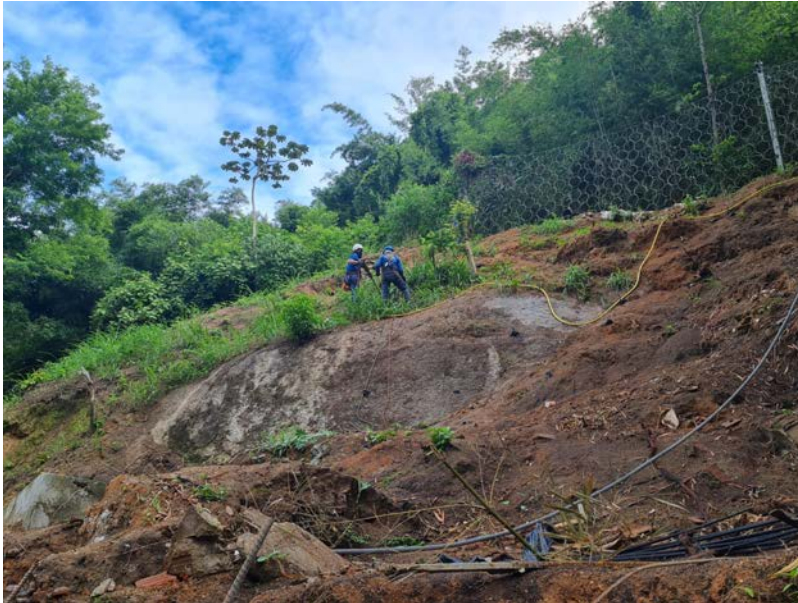
Local no início da intervenção.
