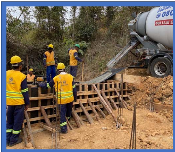
Instalação de Reservatório
