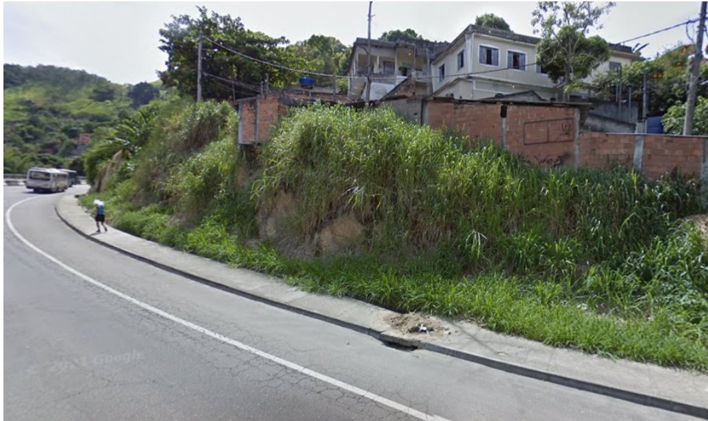
Local antes da implantação do solo grampeado, cortina atirantada e guarda corpo.
