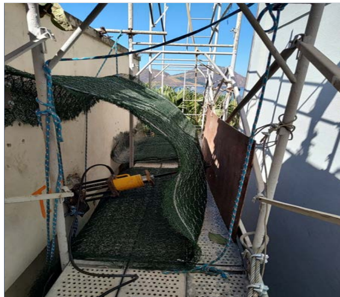
Instalação de tela, chapa de aço, e protensão de tirante
