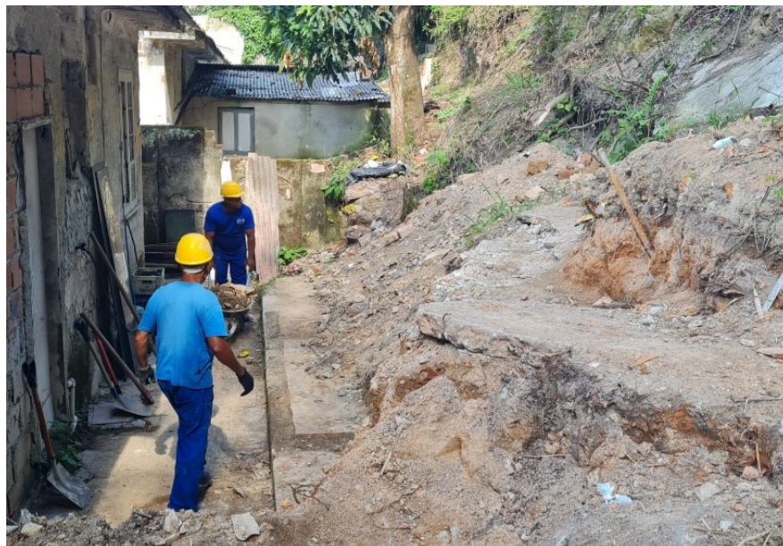
Local no início da intervenção.
