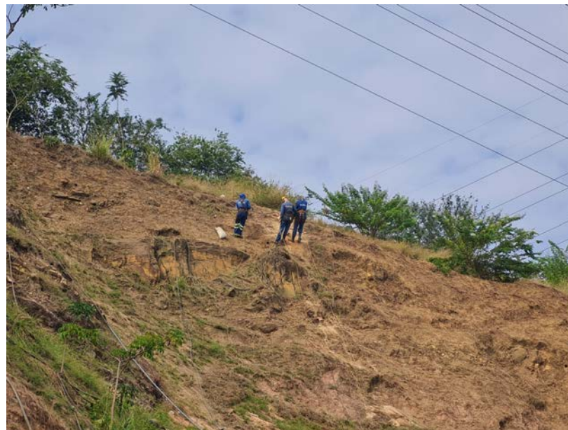
Perfuração da encosta.
