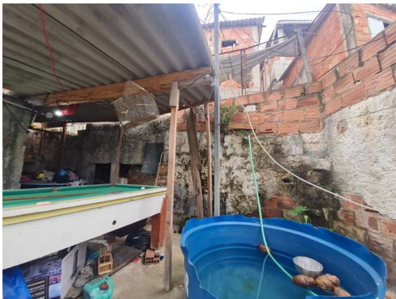
Local antes da execução da cortina atirantada.
