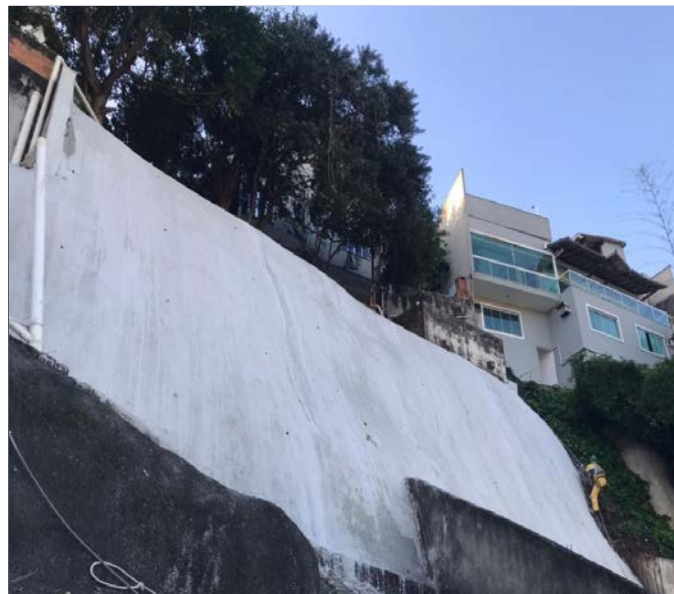
Recuperação de concreto projetado, execução de caixas de passagem e drenagem
