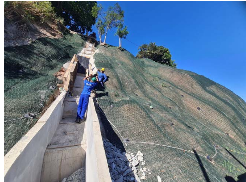
Execução da escada hidráulica e instalação da tela de alta resistência.
