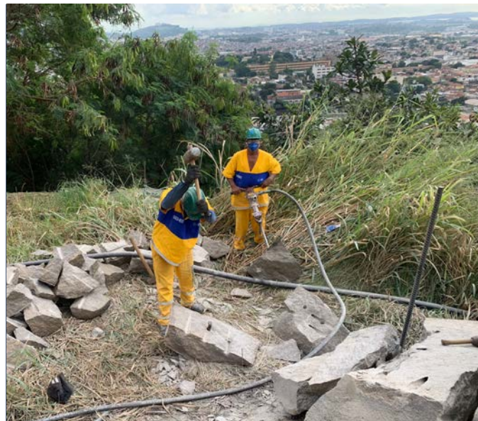
Desmonte de bloco de rocha
