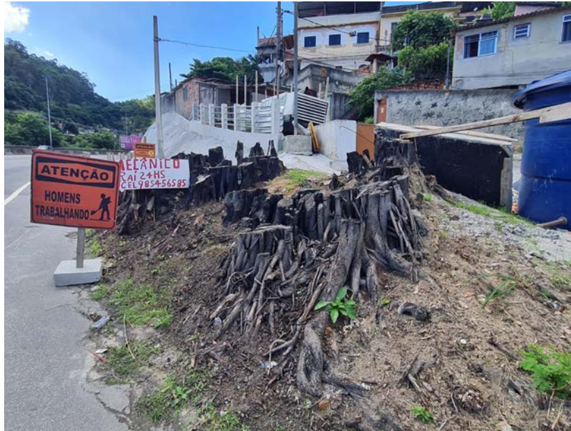
Calçada obstruída com raízes.
