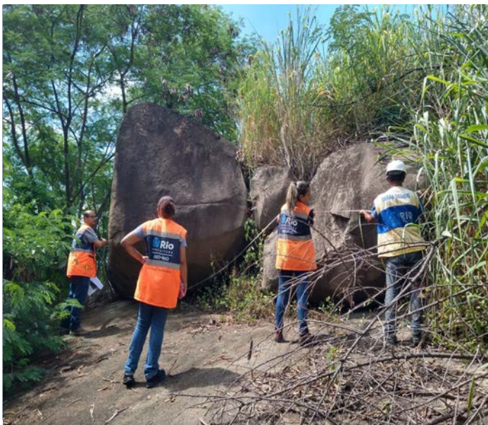
Locação da Mureta chumbada
