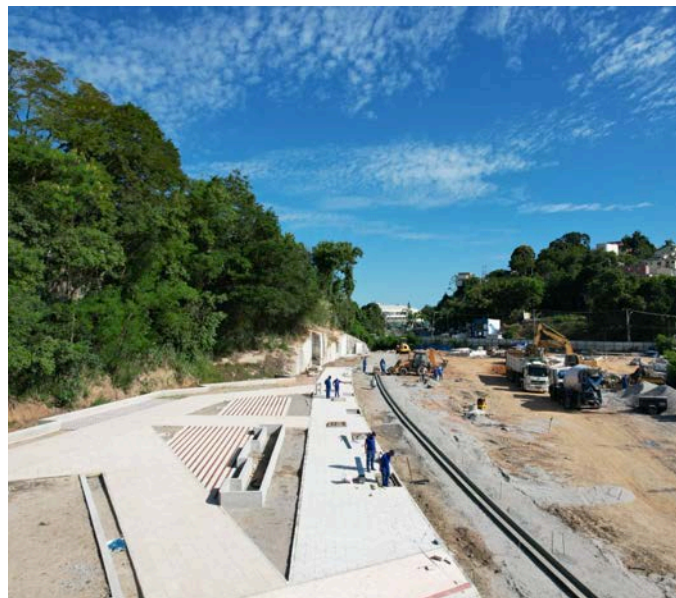
CANTEIRO/ OBRA ATUAL
