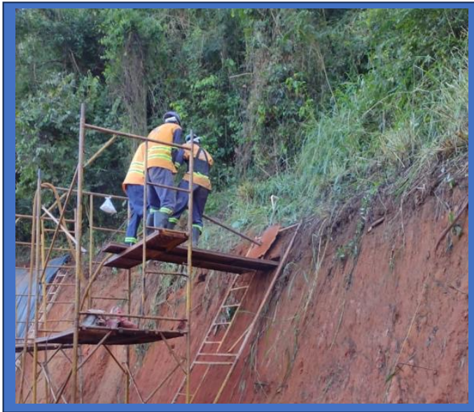
Execução de Contenções
