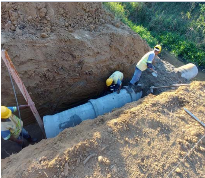
Drenagem pluvial – Deságue 600mm
