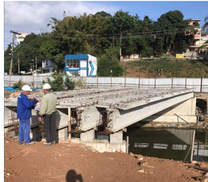
IMPLANT. SUPERESTRUTURA PONTE EIXO 600
