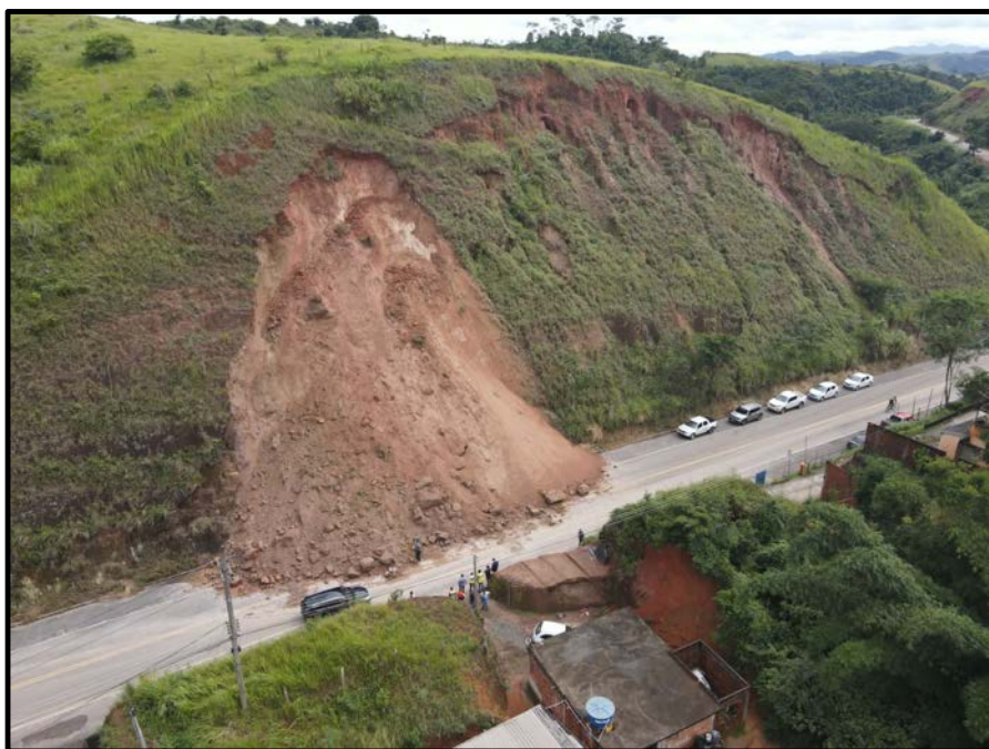
Local do deslizamento
