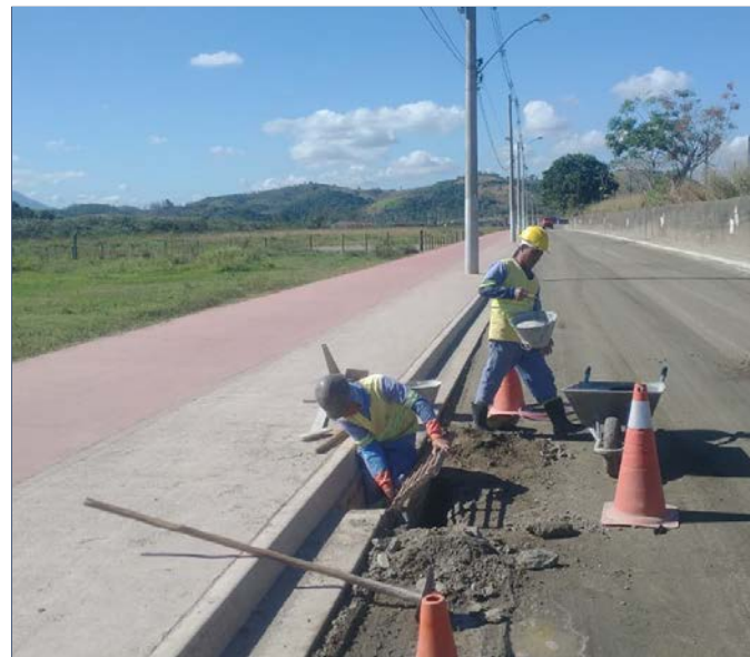
Drenagem pluvial – Acabamento em cx. de ralo
