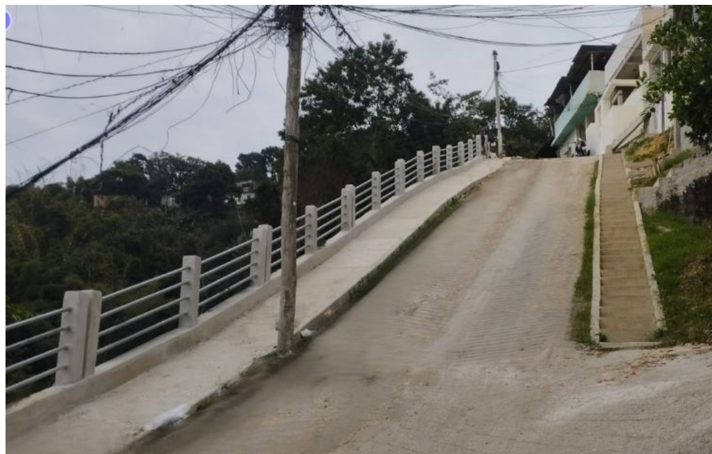
Execução de calçada, guarda corpo e escada de acesso.
