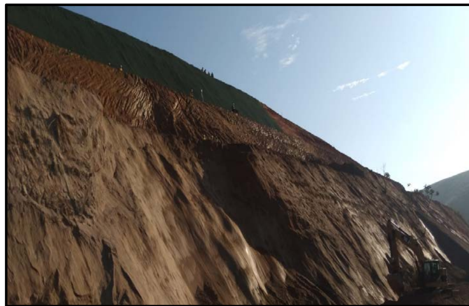
Colocação de Geomanta
