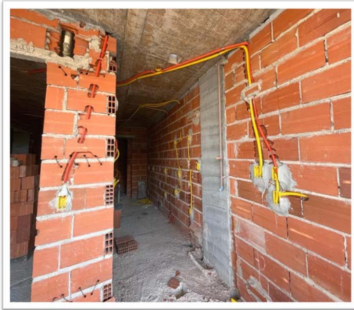
Distribuições de conduítes e caixas para instalação elétrica
