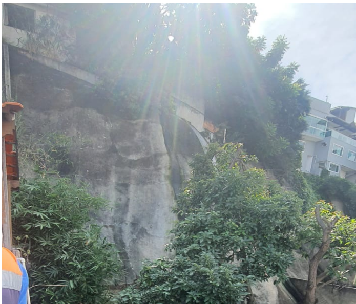
Área antes da intervenção
