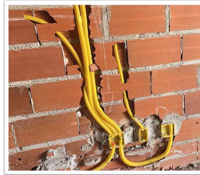
Distribuições de conduítes e caixas para instalação elétrica
