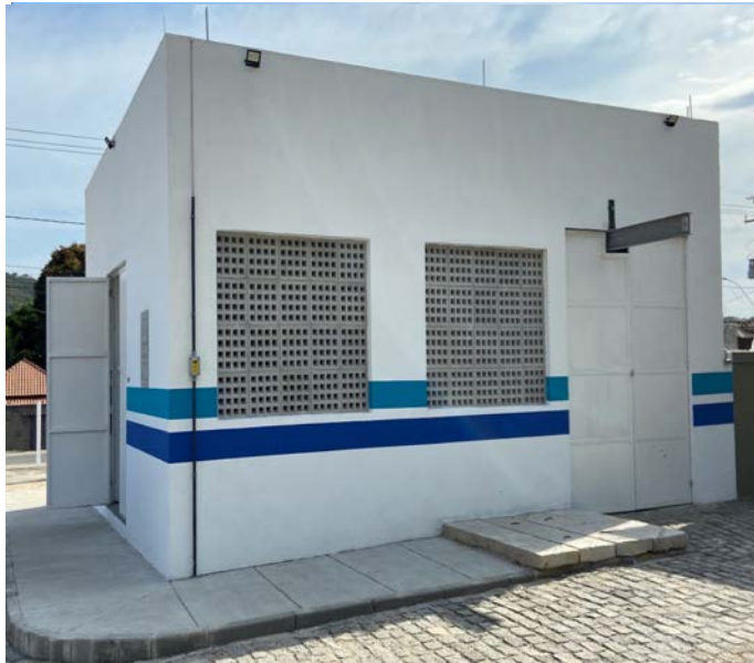
ELEVATÓRIA DE ÁGUA TRATADA
