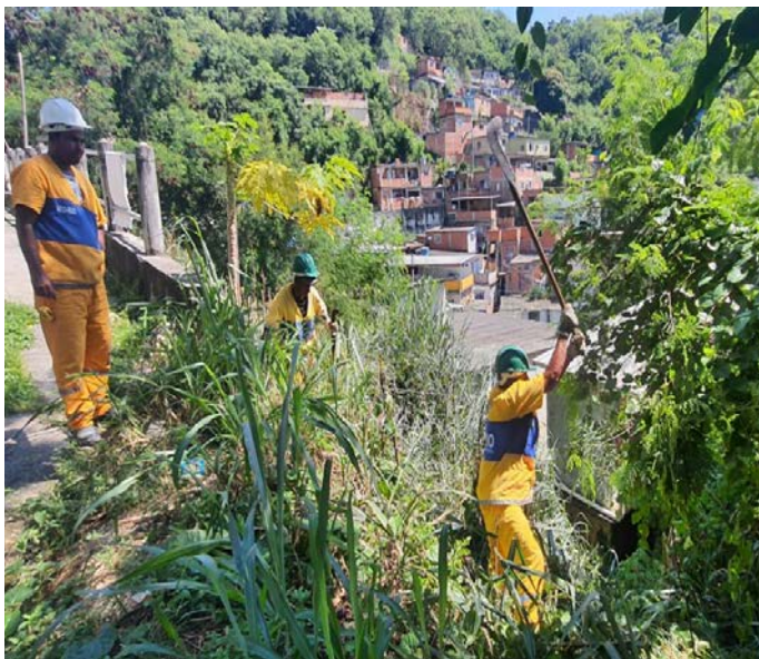
Limpeza da área de intervenção
