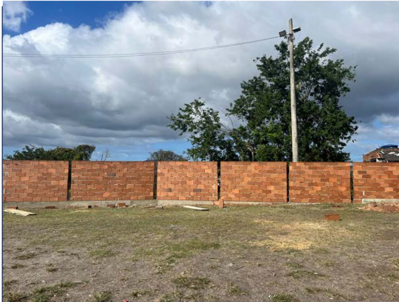
Alvenaria do muro
