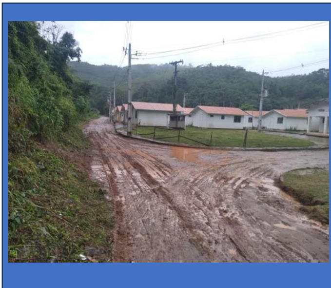
Pavimentação de intertravado e execução de calçada
