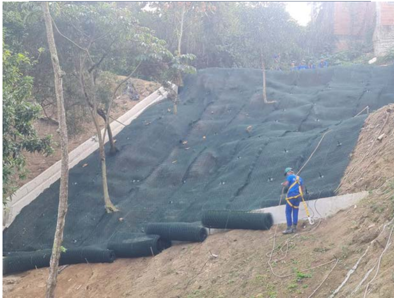
Solo grampeado revestido com geomanta.
