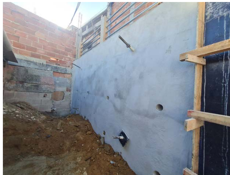
Execução da cortina atirantada.
