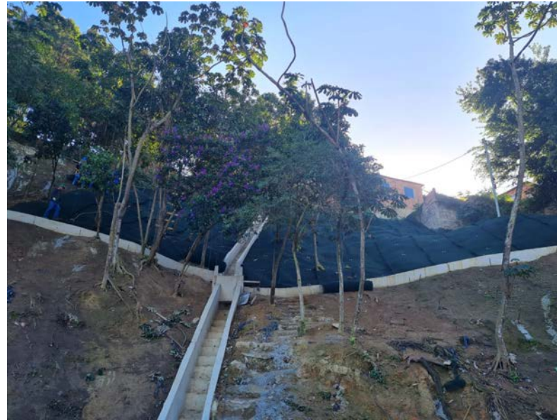
Solo grampeado revestido com geomanta.
